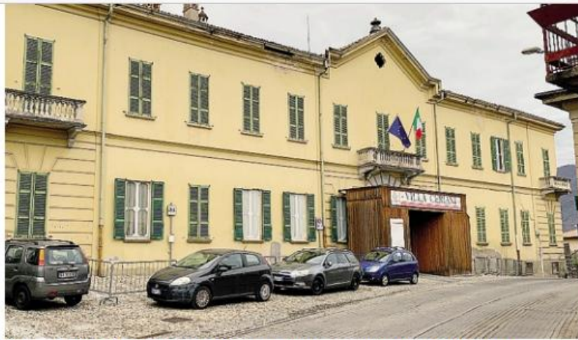
L'ingresso di Villa Ceriani, la struttura sarà interessata da importanti lavori di ristrutturazione
