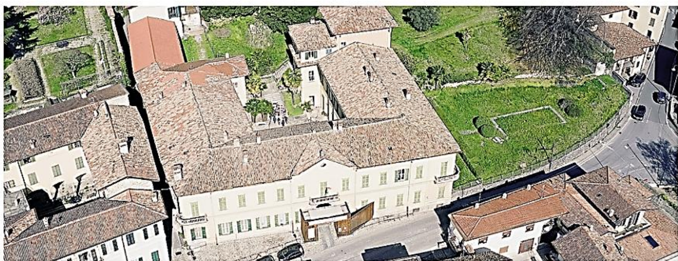
Villa Ceriani è interessata da lavori di restauro per 5 milioni di euro: il cantiere deve essere chiuso entro marzo 2026 BARTESAGHI
